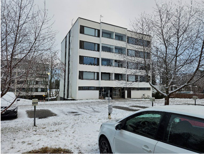
Kuva 7. As Oy Korpintornin eteläisempi rakennus (Emännäntie 21). Rakennuksen ominaispiirteitä ovat vaalea väri ja nauhamaiset ikkunalinjat. Kuva maastokäynniltä 5.12.2024 Immo Kuha / Ramboll
