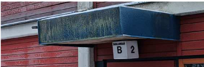
Kuva 23. Esimerkki talotyyppin 2 sisäänkäyntikatoksesta. Alapinnan väri on ulkoseinän paneelin mukainen. Katoksen pellitys ulottuu myös katoksen sivulle. Kuva maastokäynniltä 5.12.2024 Immo Kuha / Ramboll
