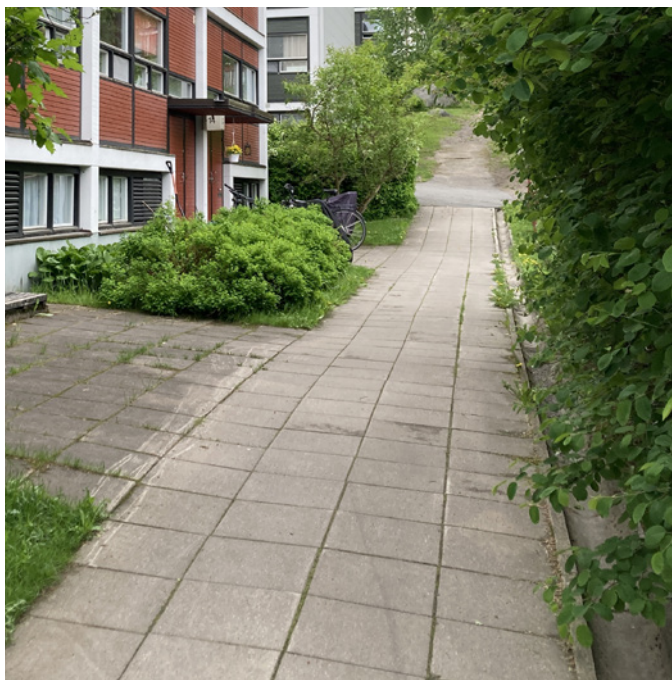
Vanha patinoitunut betonilaatta 400 x 400 mm yhdistyy suoraan istutusalueeseen. Oikealla betonikouru.
