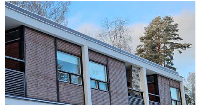
Kuva 21. Esimerkki arkkitehtonisen tyylin säilyttäneestä räystästä talotyypissä 1. Kuva maastokäynniltä 5.12.2024 Immo Kuha / Ramboll.
