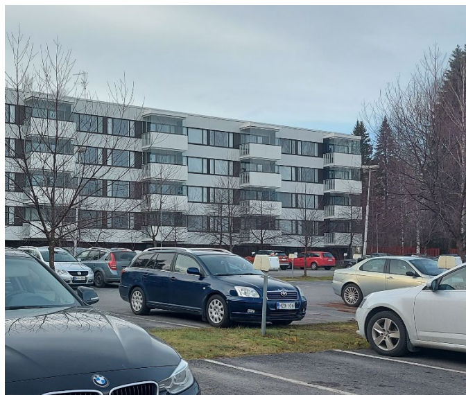
Kuva 29. Talotyypin 4 lasitettuja ulokeparvekkeita. Kuva alueen kaavoittajan maastokäynniltä 6.11.2020 Paula Julin/Jyväskylän kaupunki.
