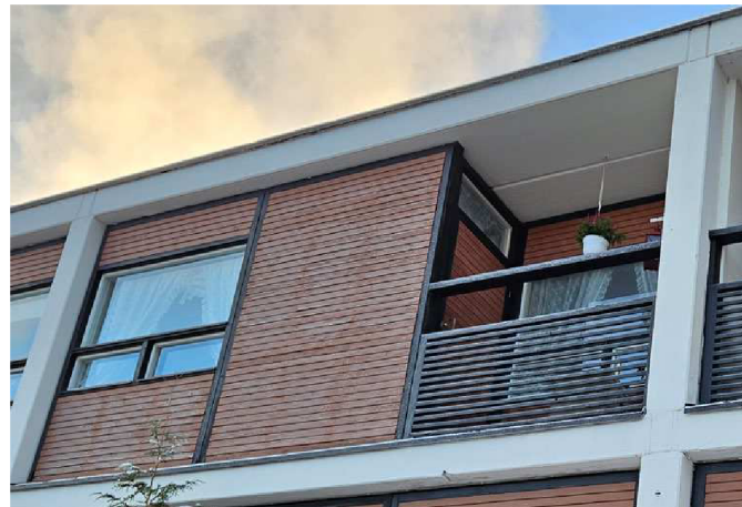
Kuva 24. Esimerkki tyyppin 1 rakennuksen parvekkeesta. Kaiteen ylin osa on samassa linjassa ikkunan kanssa. Kaiteen ja seinärungon väriyksen ovat toisiaan vastaavat. Kuva maastokäynniltä 5.12.2024 Immo Kuha / Ramboll
