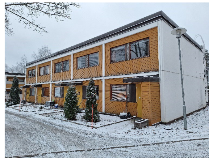
Kuva 6. As Oy Emännäntie 25 on valmistunut 1973. Korttelin 13 rakennuksille tyyppillisen julkisivuelementtien kolmijakoisuuden sijaan rakennuksissa on käytetty yhtä leveää puuelementtiä, jonka keskelle on sijoitettu kaksi suurikokoista standardi-ikkunaa. Rakennusryhmä on kuitenkin ilmeeltään yhtenäinen ja arkkitehtuurin eroista huolimatta myös nämä myöhemmät Eskelisen rakennukset kuuluvat selkeästi osaksi alueen kaupunkisuunnittelullista ja kaupunkikuvallista kokonaisuutta. Kuva maastokäynniltä 5.12.2024 Kirsikka Siik / Ramboll.
