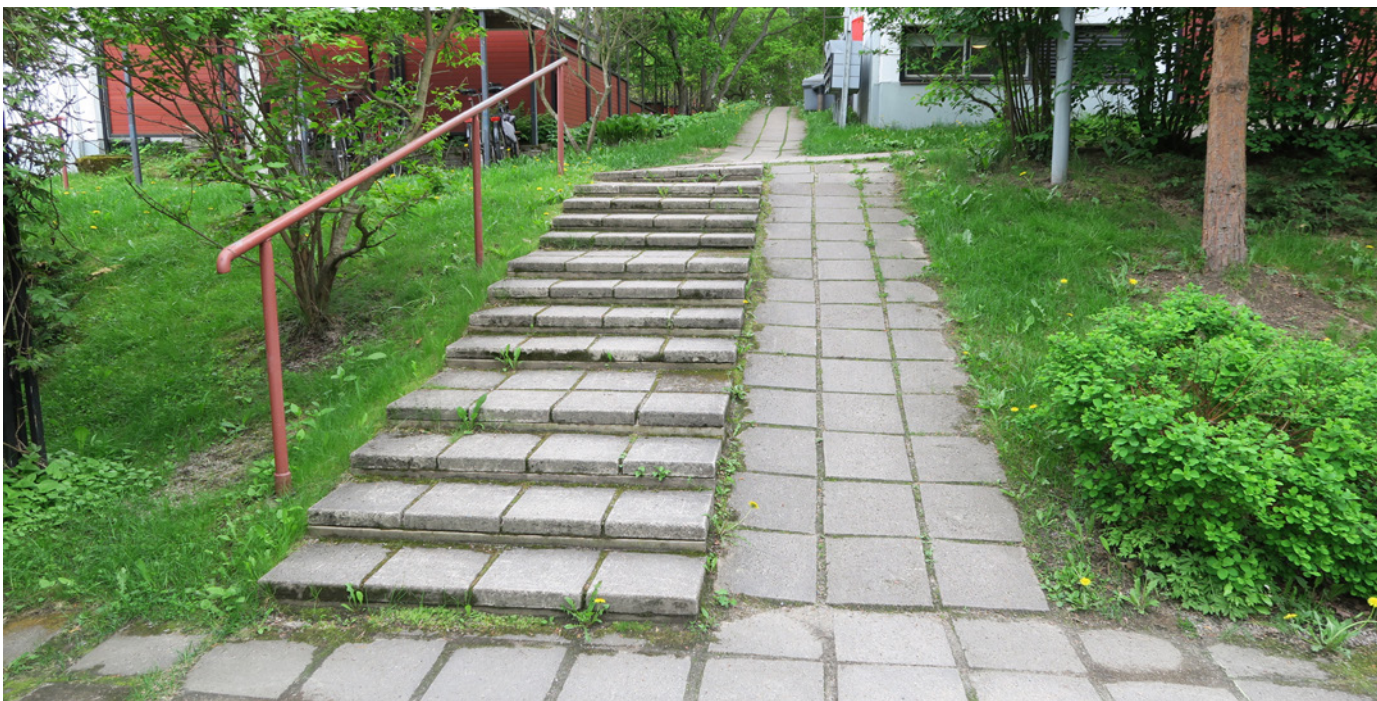
Esimerkki alueen alkuperäisen tyylin mukaisesta portaasta, johon liittyy käsijohde ja pyöräntalutus-/vaunuluiska. Luiska ei ole esteetön.
