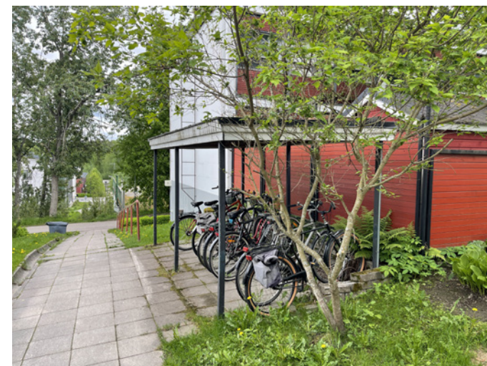
Kevytrakenteinen pyöräkatos sopii alueen arkkitehtuuriin. Korkeus on riittävä pyörien runkolukitukseen.
