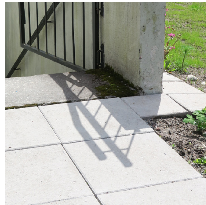
Uusittua betonilaattaa isommassa 500 x 500 mm ja pienemmässä 300 x 300 mm koossa. (Kuva Leena Buller 2022)
