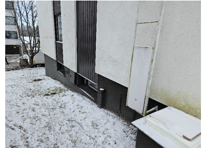
Kuva 28. Ulkoseinän lisäeristys kerrostalossa. Julkisivun lisäeristetty pinta on ulompana kuin lautaverhoitu julkisivupinta. Kuva maastokäynniltä 5.12.2024 Immo Kuha / Ramboll
