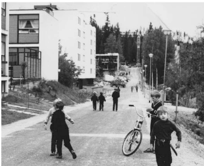
Emännäntieltä otetussa valokuvassa näkyy alueen rakentamisajankohtana käytetty valaisinpylväs (kuva: Seppo Turpeinen 1969-71, Keski-Suomen museo).
