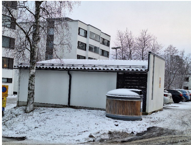
Kuva 33. Pysäköintitontilla 13-8 sijaitseva ulkorakennus poikkeaa alueen muista piharakennuksista siinä, että se mukaillee rakennusmateriaaleiltaan ja ilmeeltään viereisten kerrostalojen ilmettä. Kuva maastokäynniltä 5.12.2024 Kirsikka Siik / Ramboll
