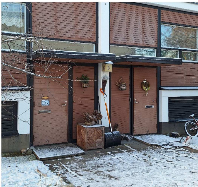
Kuva 26. Sisäänkäynnin numerovalaisin sijoitettuna katosten väliin. Kuva maastokäynniltä 5.12.2024 Kirsikka Siik / Ramboll.
