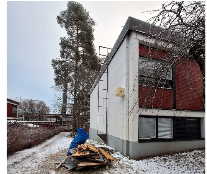
Kuva 25. Alkuperäinen Lundstenin ja Kahrin suunnittelema tikastyyppi. Alkuperäiset tikkaat tulee säilyttää. Kuva maastokäynniltä 5.12.2024 Kirsikka Siik / Ramboll
