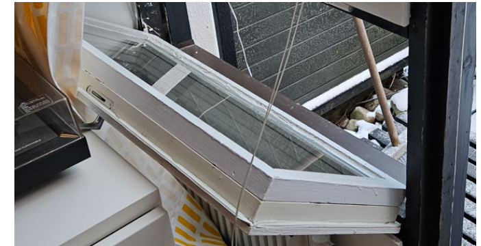
Kuva 15. Tyyppin 1 rakennusten alkuperäiset ikkunat ovat profiililtaan paksuja, runkoon kiinnitettyjä ja yläosasta avautuvia. Kuva maastokäynniltä 5.12.2024 Immo Kuha / Ramboll
