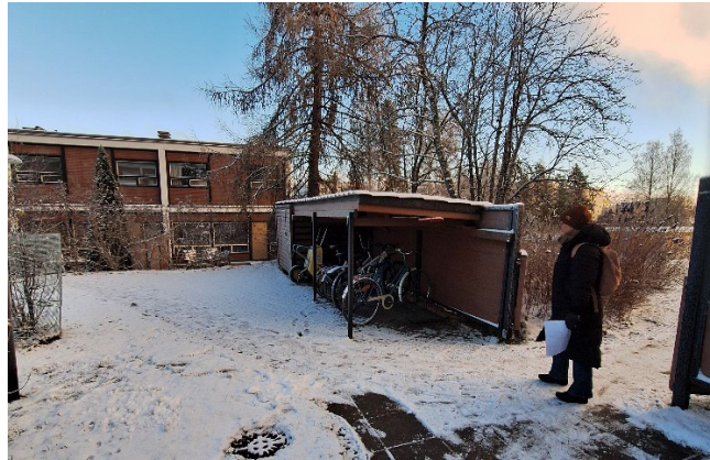
Kuva 31. As Oy Auvilanperä 1:n tontilla 13-1 on matala ja kevytrakenteinen pyöräkatos, johon liittyy pieni lukittava ulkovarastotila. Rakennelma yhdistyy suoraan tonttia Auvilankujan puolella rajaavaan aitaan. Pyöräkatoksen on pyritty myös värityksellä sovittamaan korttelin rakennuskantaa. Kuva maastokäynniltä 5.12.2024 Kirsikka Siik / Ramboll
