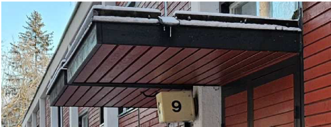
Kuva 22. Esimerkki tyyppin 1 rakennuksen sisäänkäyntikatoksesta. Alapinnan väri on ulkoseinän paneelin ja reunalaudoitus seinärungon väriyksen mukainen. Katoksessa on käytetty toivottua kevytilmeistä pellitystapaa. Kuva maastokäynniltä 5.12.2024 Immo Kuha / Ramboll
